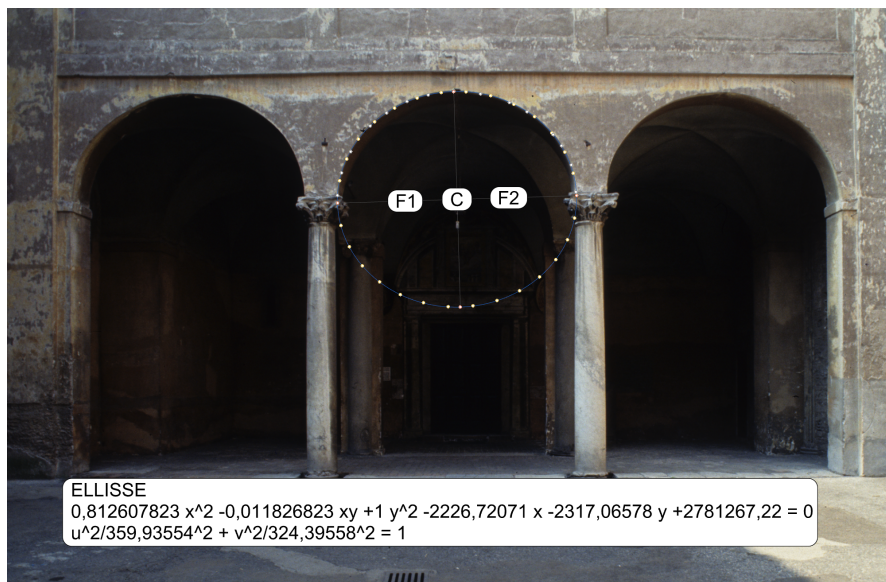
Figura 54 Analisi del profilo di un arco: la curva costruita per cinque punti, un'ellisse, è messa a confronto con la curva di approssimazione costruita su un ricco campione di punti
